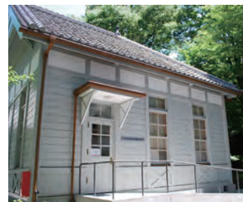
改修後（同左：2020年6月撮影）
