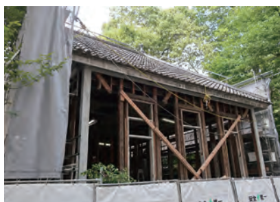
改修中（通用口側：2019年8月撮影）
