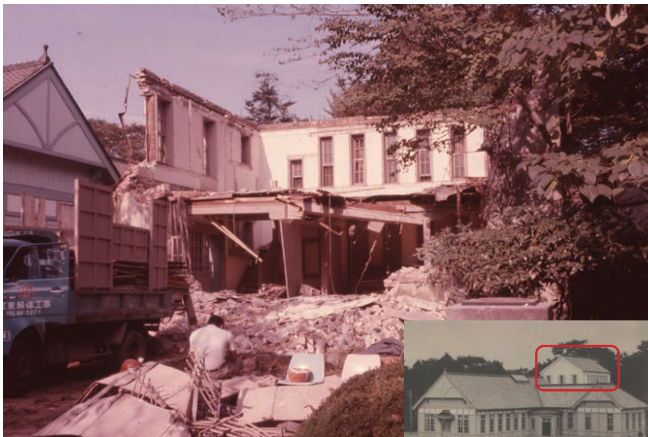
北別館（旧図書館）書庫 解体風景 1977（昭和52）年頃
