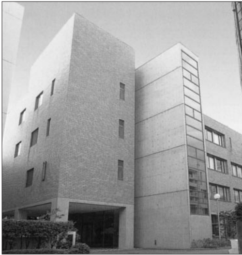
大生命分子科学研究所棟 南6号館（目白校地） 平成4年（1992年）11月竣工 地上5階、地下ピット 建築面積 482㎡ 延床面積 1,867㎡ 生命分子科学研究所、実験室等
