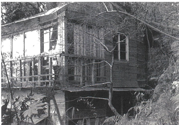
大磯の家。家の中央には太い松の木が床から天井まで突き抜けていたという
