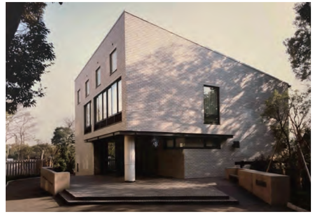
打込みタイルの南5号館（竣工時）
