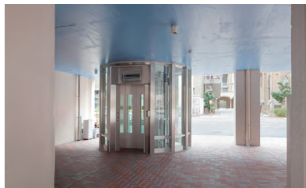
新たに円形エレベーターを設置（南2号館）
