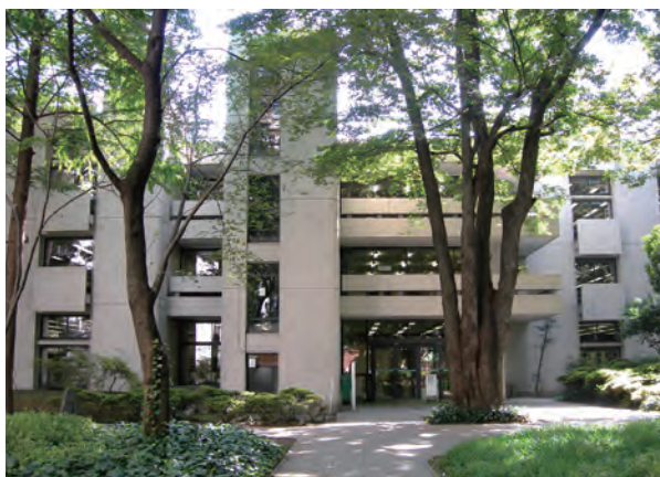
一部床梁にPC工法を採用した大学図書館
