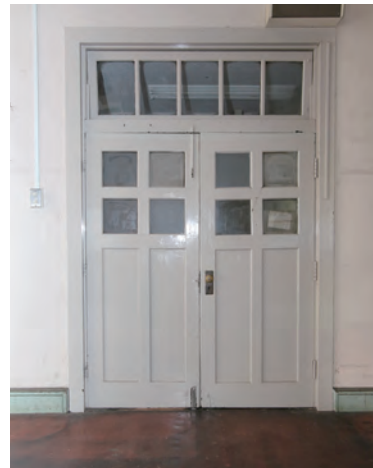
⑥ 1階女子部生徒課倉庫 上部欄間の右端の一枚が「銀線」ガラスである
