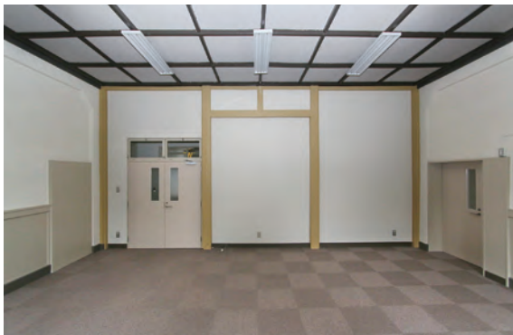
⑤ 2階女子部国語科準備室、北面を見る。かつて入口だった二本一組の木柱の上に鴨居と束が見える
