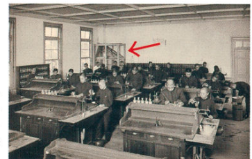
大正時代の化学実験風景。箱型タイプのドラフトチャンバーが据え付けられていた（『大札奉獻学習院写真』より）
