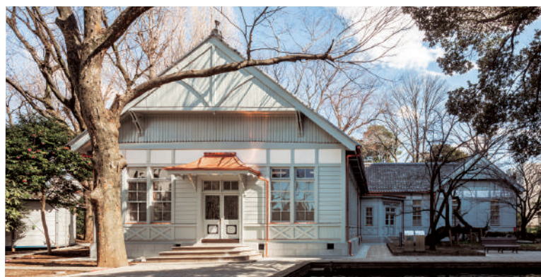
明治期の学校建築として貴重なこの建物は、国登録有形文化財に登録されている
