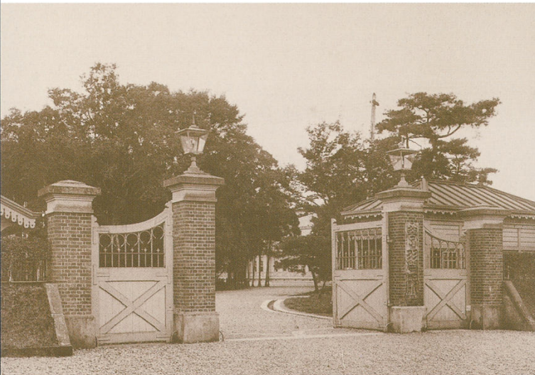
頭部に照明が設置されている開校当時の正門。
