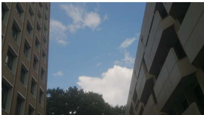
【中央教育研究棟・北1号館】
