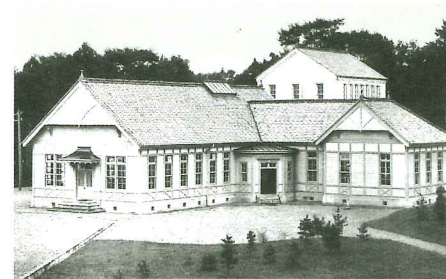
図書館竣工時の写真
