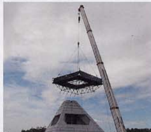
⑥足場取り外し(4月19日)
