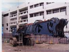
⑧解体車両組み立て途中(4月21日)
