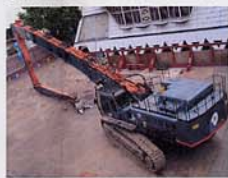
⑨解体車両完成(4月21日)
