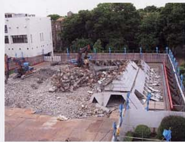
⑪ほぼ解体された中央教室(5月12日)
