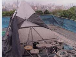
④大型カッターで切断(4月18日)
