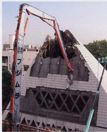
⑩解体作業中の様子(4月25日)
