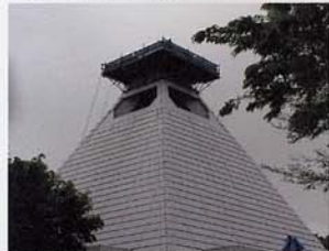
③最上部に組まれた足場(4月17日)
