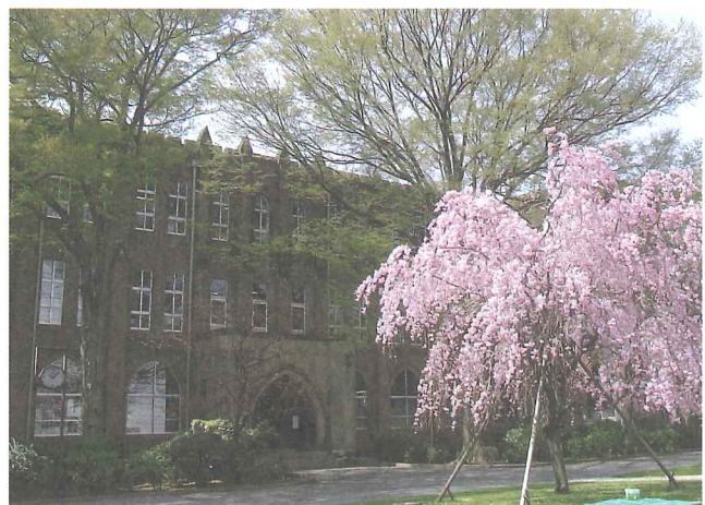
改修前の南1号館(平成21年頃)
