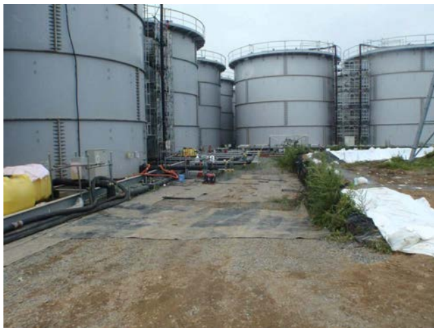
図2 福島第一原子力発電所 H4 エリアに並ぶ汚染水用のタンク。右側にはどこの土嚢が積まれている。2013 年 9 月 6 日。東京電力提供。
